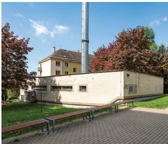
Současný vzhled výměníku
