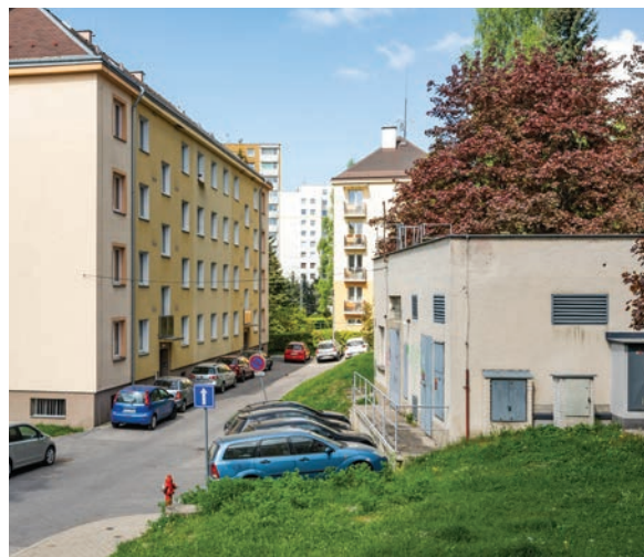
Současný vzhled výměníku
