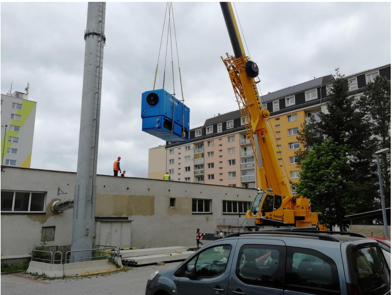
Zdroj Z9, instalace kogenerační jednotky, sídliště Mšeno
