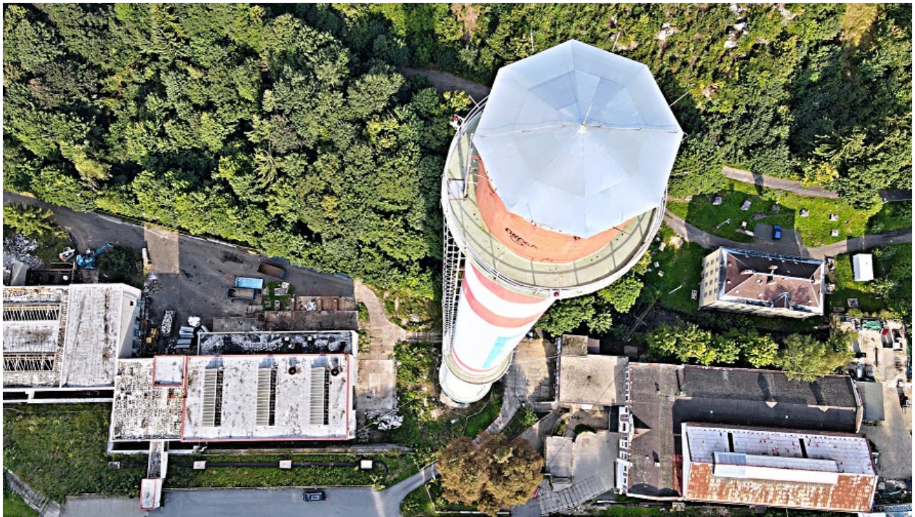
Detail ochranné střechy komínu Brandl před zbouráním
