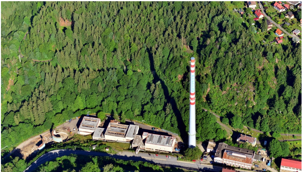
Pohled z dronu na výtopnu Brandl před její demolicí 25.9.2021
