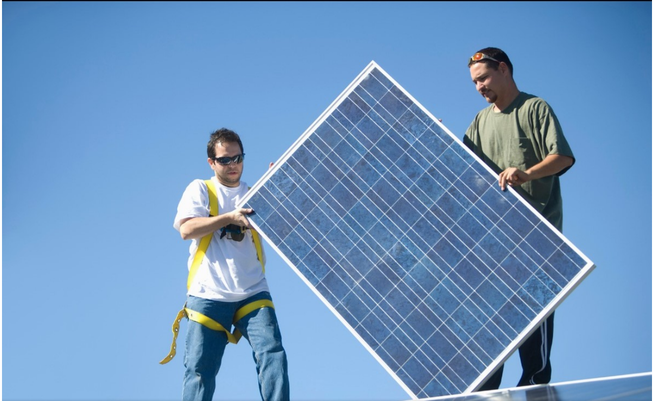
Montáž fotovoltaických panelů na zdroji Z9 Boženy Němcové
