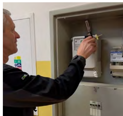
Instalace optických snímačů
