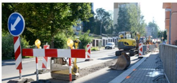
Výkopy a dopravní omezení v průběhu revitalizace Jablonečané zvládli na výbornou
